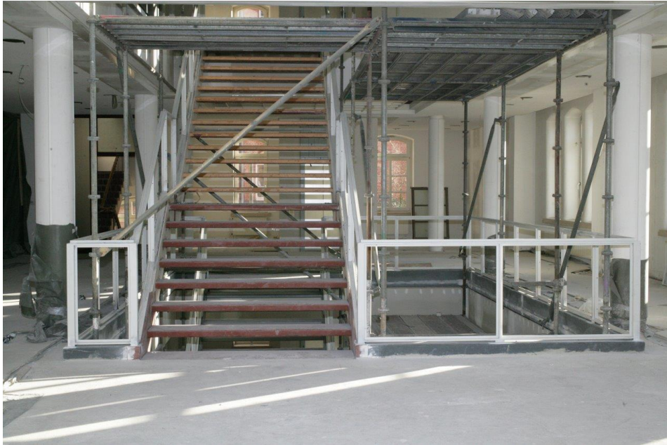
Alles barrierefrei: Noch verbirgt das Gerüst den neuen Fahrstuhl beim Treppenaufgang im künftigen Lern- und Informationszentrum. Foto: Frauke Proschek
